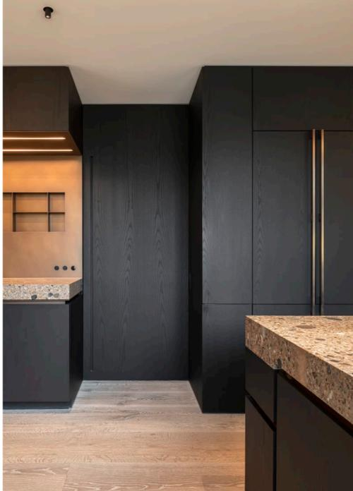
Während die Fronten aus lackierter Esche gefertigt sind, bestehen die Korpusse aus Röhchereichen-Furnier mit matt lackierter Oberfläche, die Schubladen aus massiver Röhchereiche. (Foto: Oliver Jaist)
